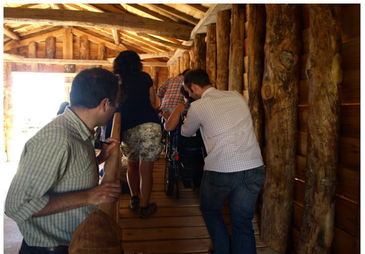
Figura 7 - Rampa de acesso ao observatório (problemas detetados).
